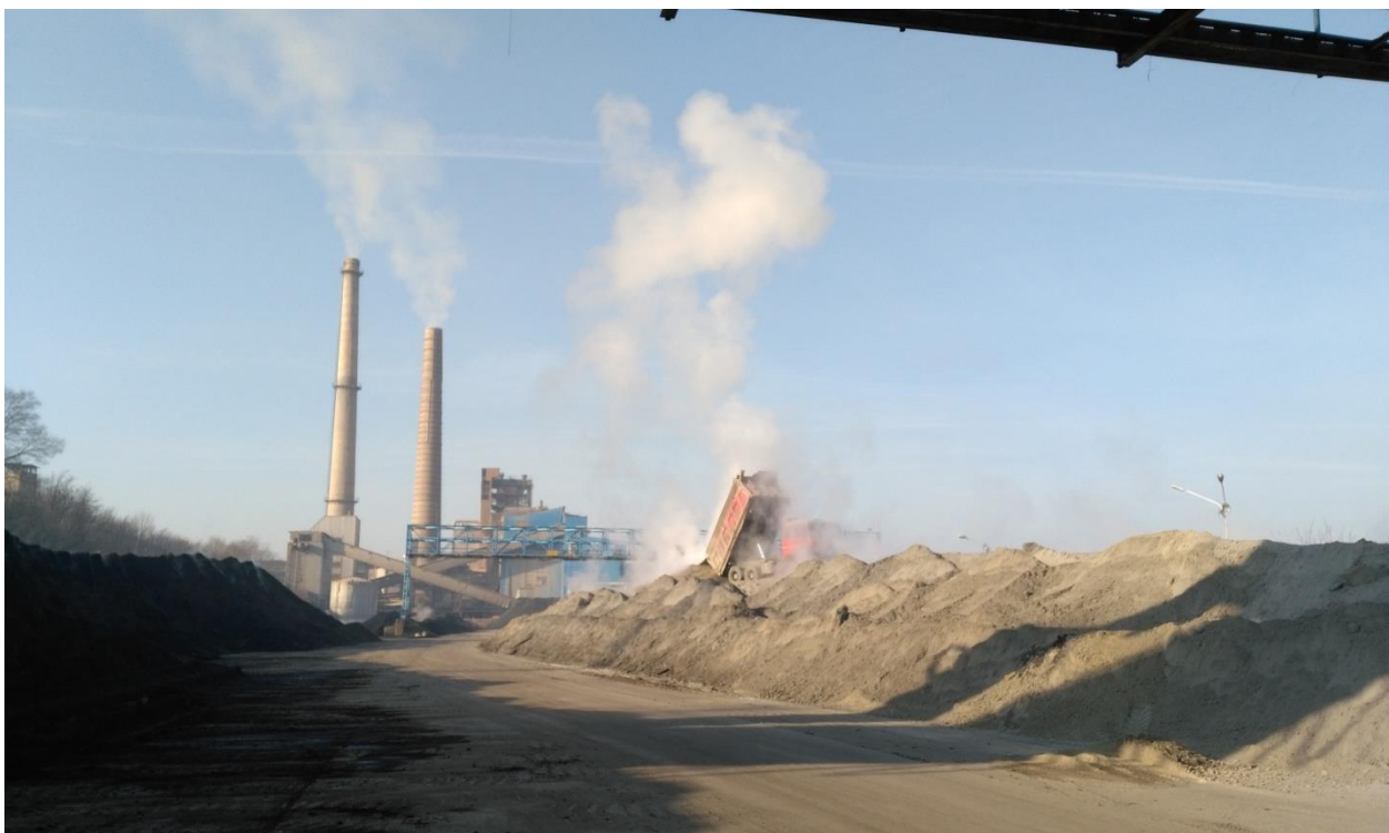
Slika 8 Izgled deponije uglja i pepela u samom centru grada Kragujevca
