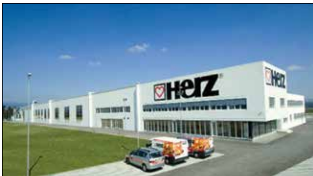
Nova fabrika kotlova na biomasu u Pinkafeldu, Austrija
