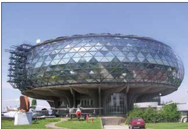
Слика 1. Застакљени омотач зграде музеја и бетонска конструкција објекта
