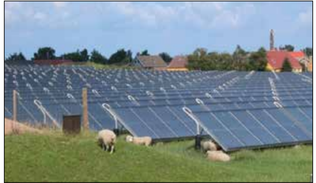
Slika 2. Solarna toplana Marstal u Danskoj sa ravnim pločastim TPSE (foto: Erik Christensen)
