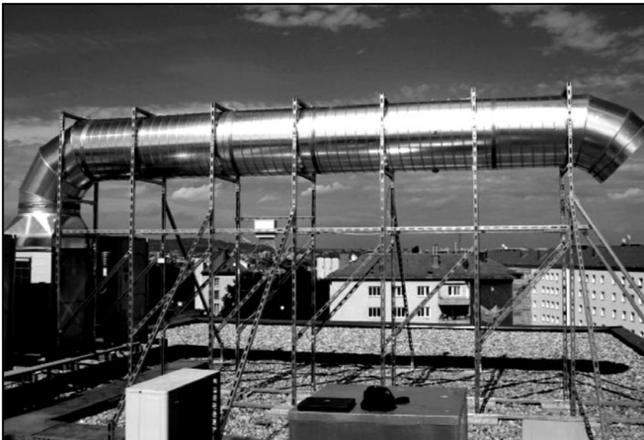
Slika 1. Instalacija platforme za merenje
