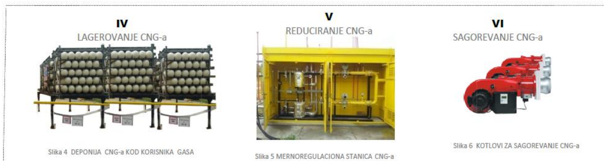
Slika 5 MERNOREGULACIONA STANICA CNG-a
