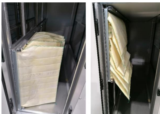
Slika 6. Primer pravilne i nepravilne ugradnje filtera
