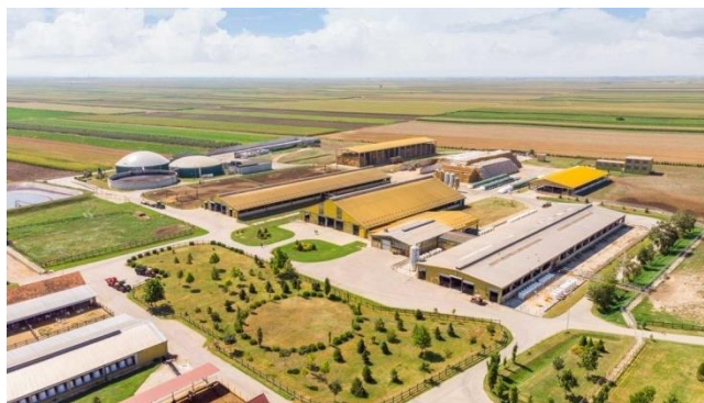
Slika 3. Elektrana na biogas kapaciteta 1,27 MW
