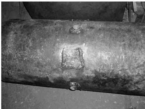
Slika 5. Cijevne sekcije s poznatim defektima koji su remontovani pod vodom
