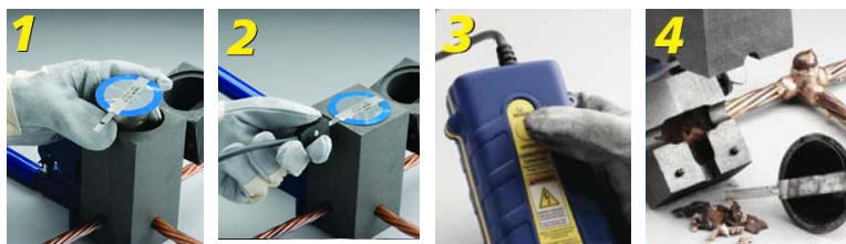
Slika 15. Postupak CADWELD® PLUS egzotermičkog zavarivanja spojeva
